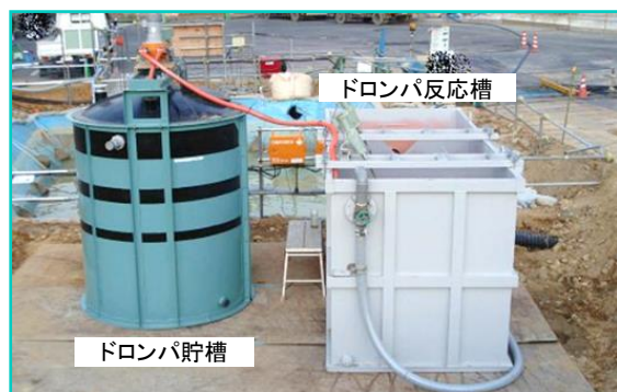
ドロンパ設備施工例
