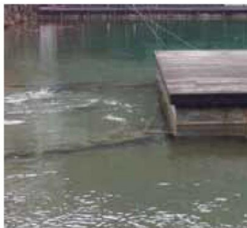
写真: 現地の様子
